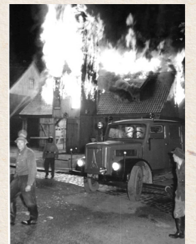
Brand des alten Gebäudes
